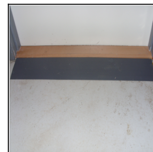
Rampa pronta per l'uso
