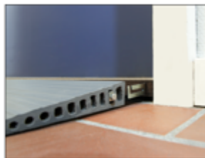
Staffa di fissaggio montata nel gradino della porta
