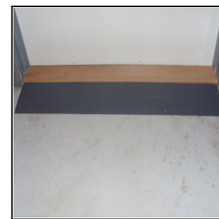
Rampe klar til brug
